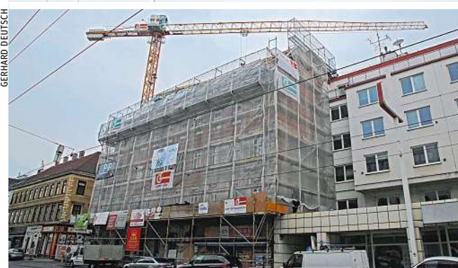
Die Fertigstellung der Arbeiten ist für Dezember 2017 geplant
