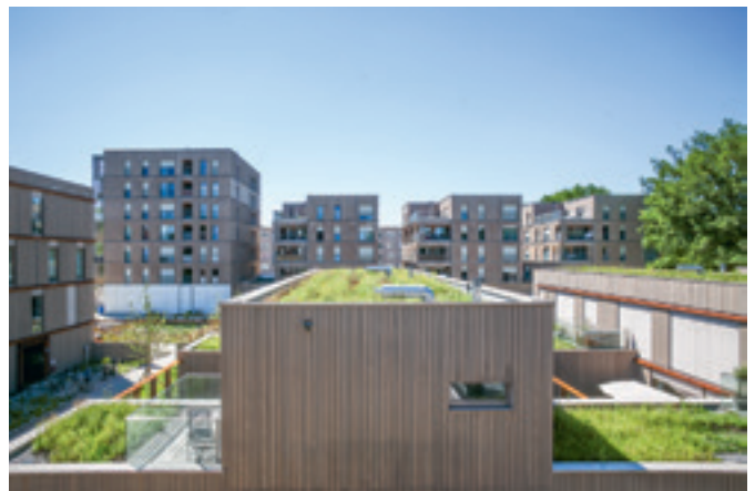
Abb. 19: Wohneinheiten in Holzbauweise © Lukas Vallentin
