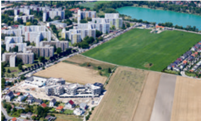
Abb. 4: Baufläche für das Projekt Berresgasse © C. Fürthner
