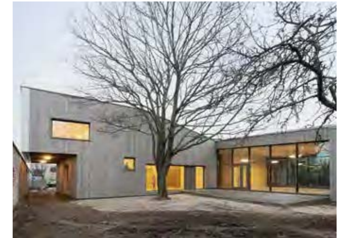
Nordwestfassade, offener Bereich, Kinderbereich
