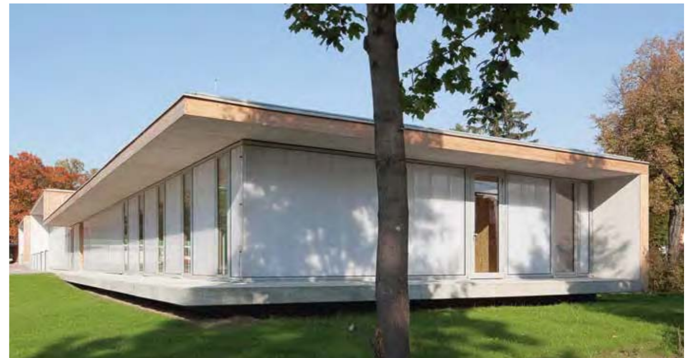
Büros mit wettergeschütztem Vorbereich
