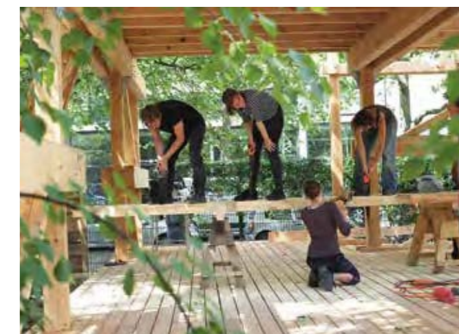
Bau der Treppe
