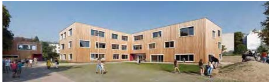
Südostfassade, Haupteingang Johannes-Schule-Berlin
