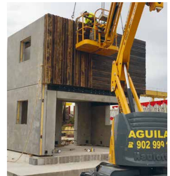
Prototyp: reversibles Fassadenelement aus Altholz
