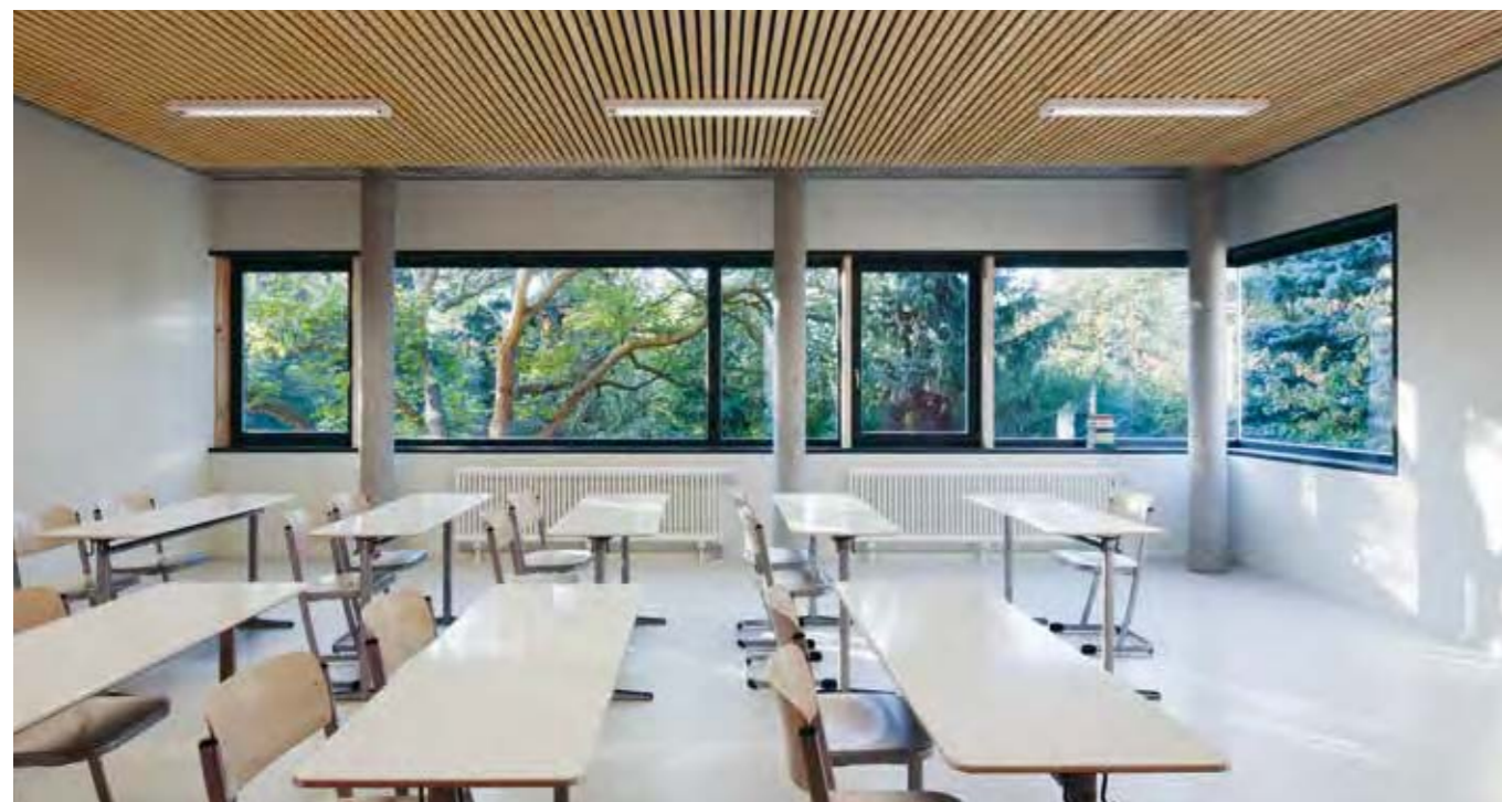
Klassenraum mit Holzakustikdecke
