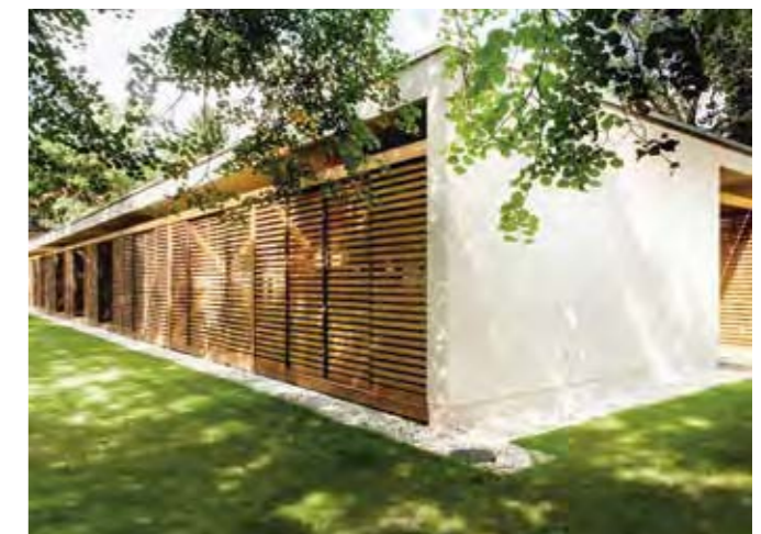
Verschiebbare Holzlamellen als Sonnenschutz
