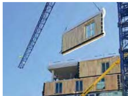
Montage Holzelementfassade
