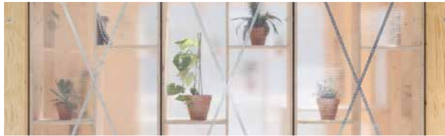
Fassadendetail mit Gitterfolie
