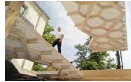
Einbau der Deckenelemente
