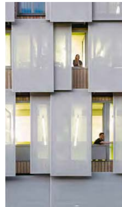
Textilfassade aus verschiebbaren Rahmen
