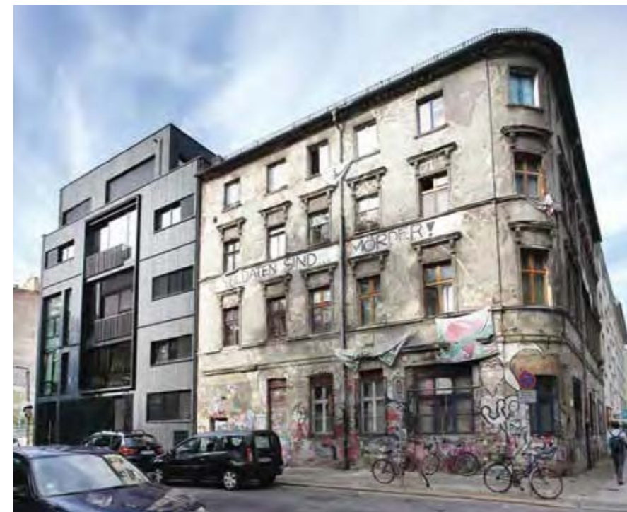
Straßenansicht mit Nachbarn
