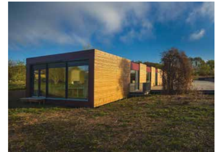
Aufbau der Module im Gelände
