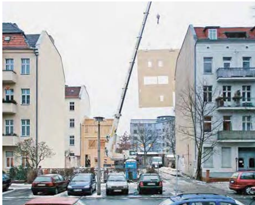
Montage der vor Ort gefertigten Wandteile
