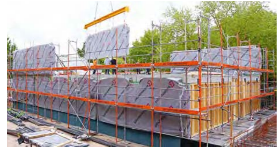
Montage der tragenden Außenwand
