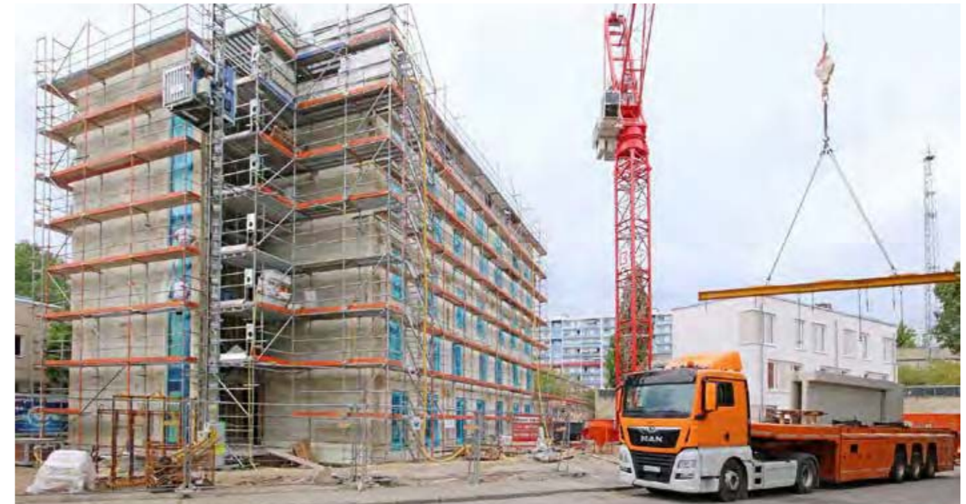
Bautenstand nach 4 Monaten
