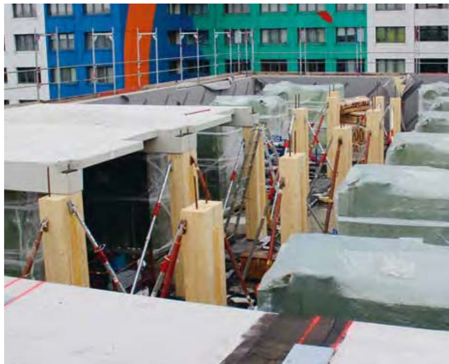
Rohbau mit tragenden Holzelementen, Nasszellen und Stahlbetondecken
