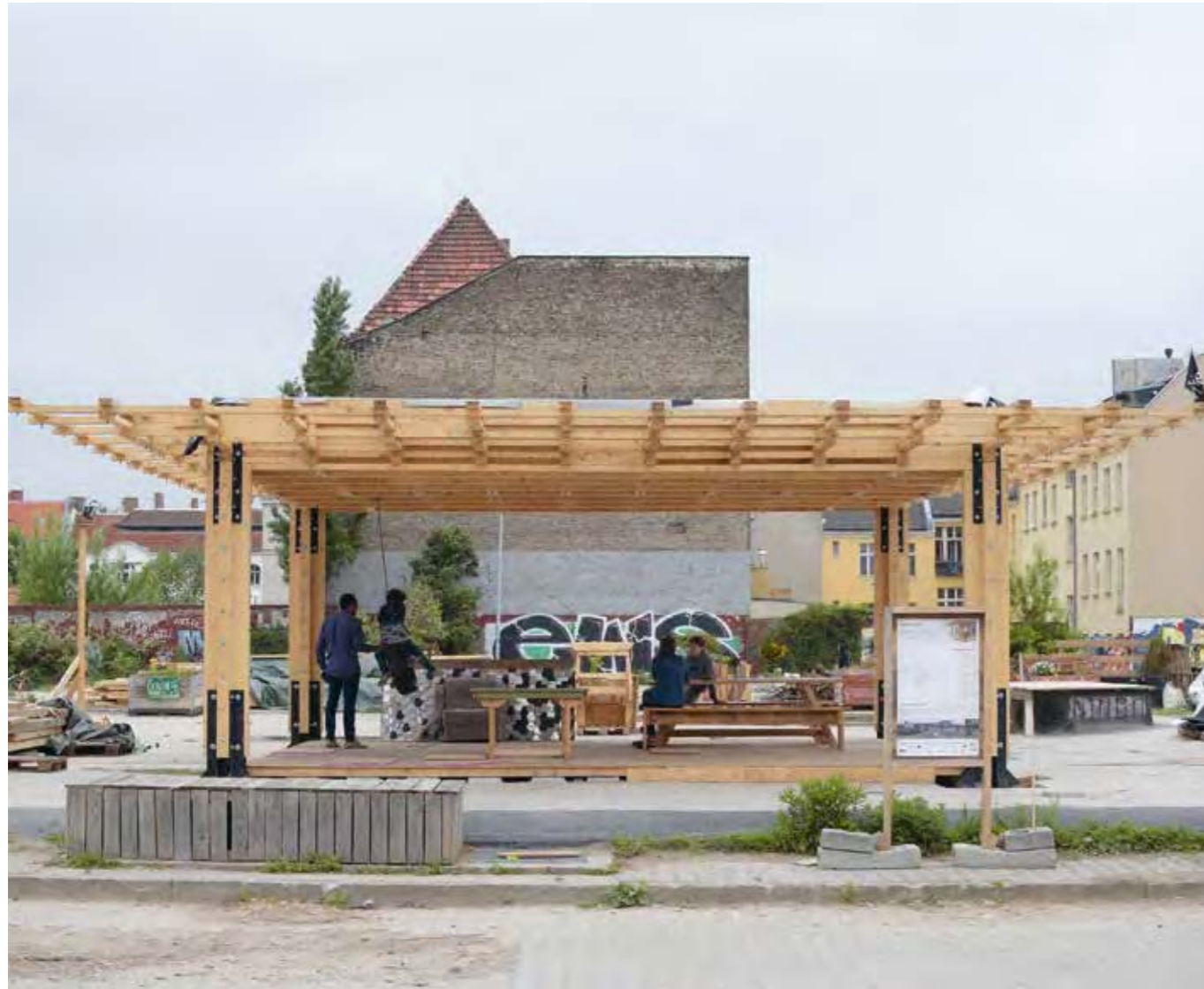
Ansicht nach Fertigstellung des Daches
