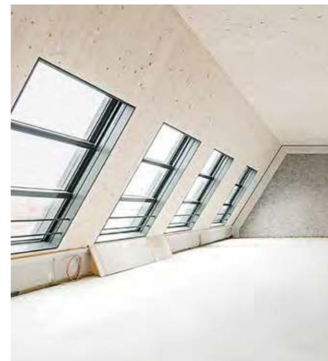
Innenraum mit sichtbarem Holzfaltwerk ohne Randpfette
