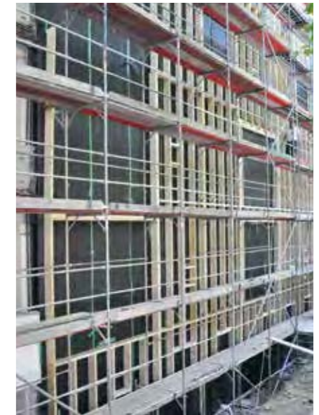
Holzständerkonstruktion im Bau
