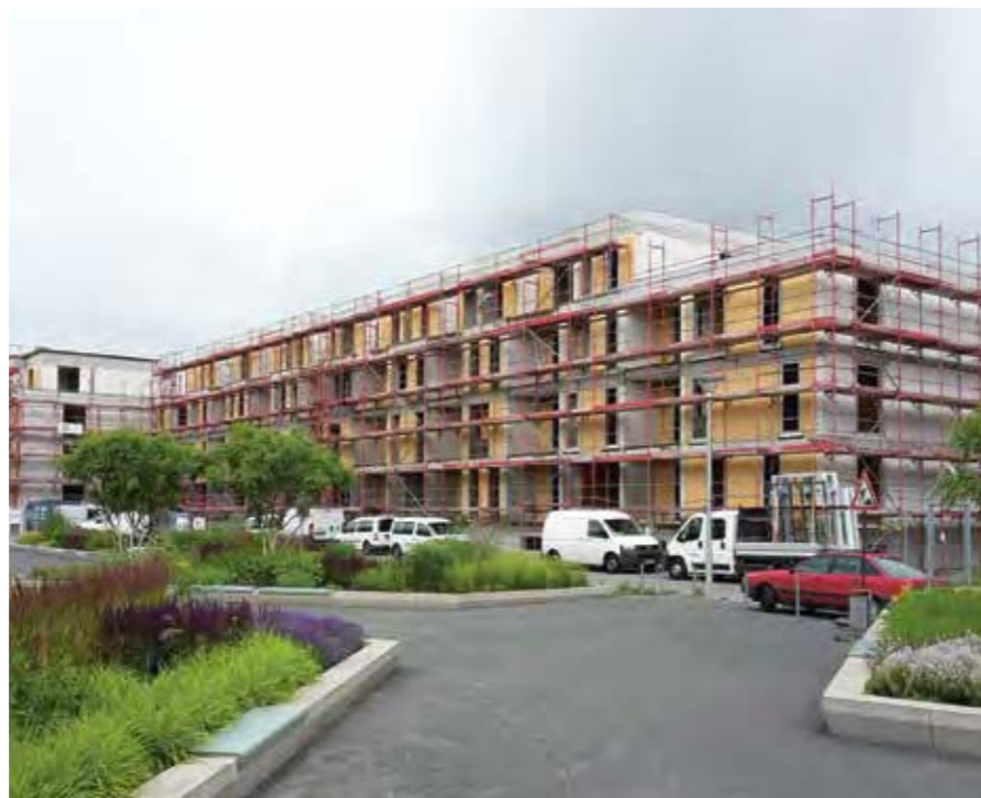
Montage der Holzelementfassade
