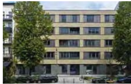
Straßenansicht – Bekleidung und Konstruktionsphase
