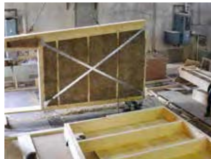
Holzständerkonstruktion
