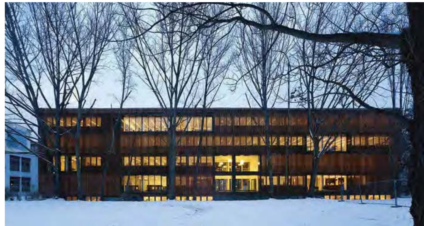
Blick auf die Aufenthaltsräume
