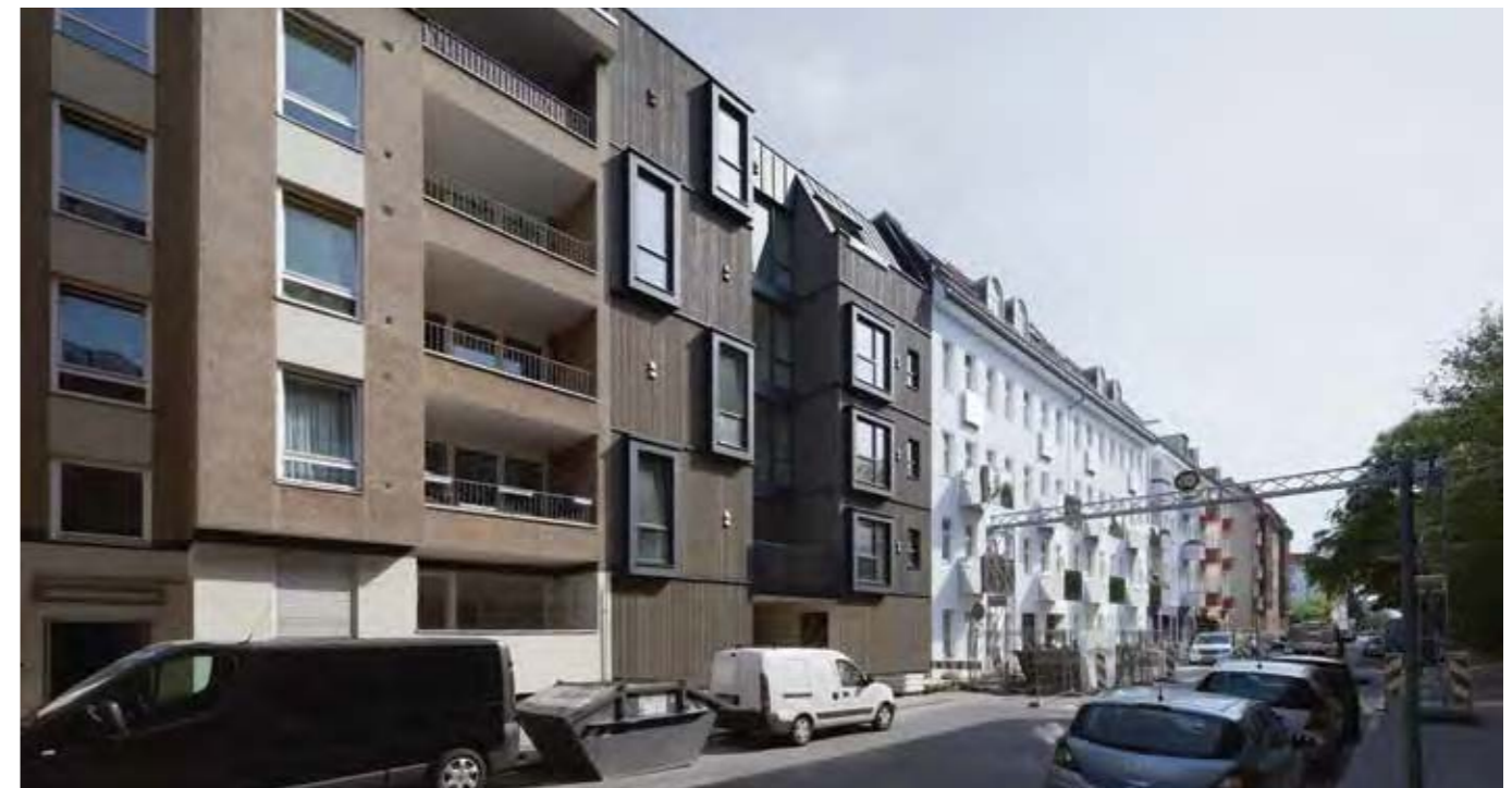
Gebäude in der Straßenflucht
