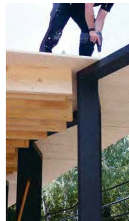
Konstruktion Fassadenanschluss
