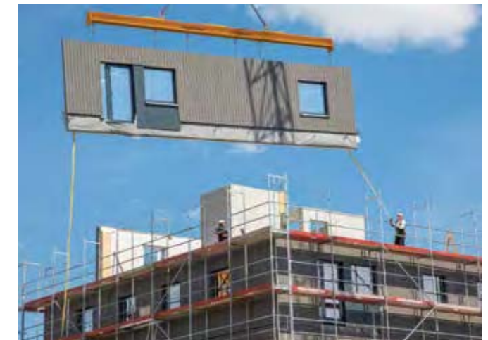
Montage vorgefertigter Holzbauelemente
