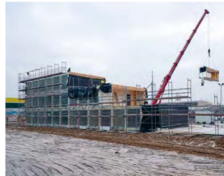
Montage der Holzmodule
