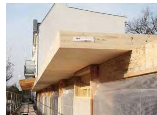
Auskragende Deckenplatte und Holzfassade
