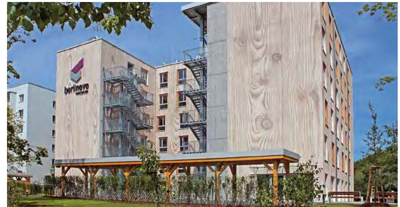
Gebäude nach Fertigstellung
