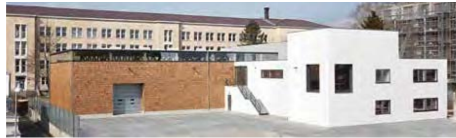
Südfassade mit Haupteingang
