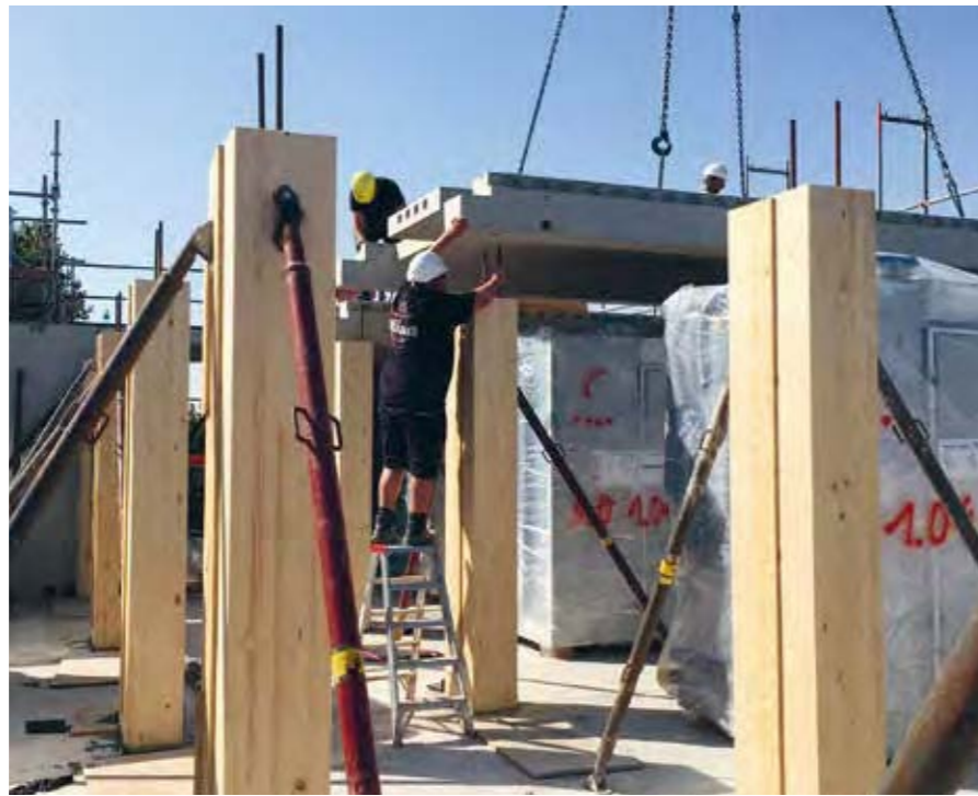
Montage Stahlbetondecke auf tragenden Holzstützen
